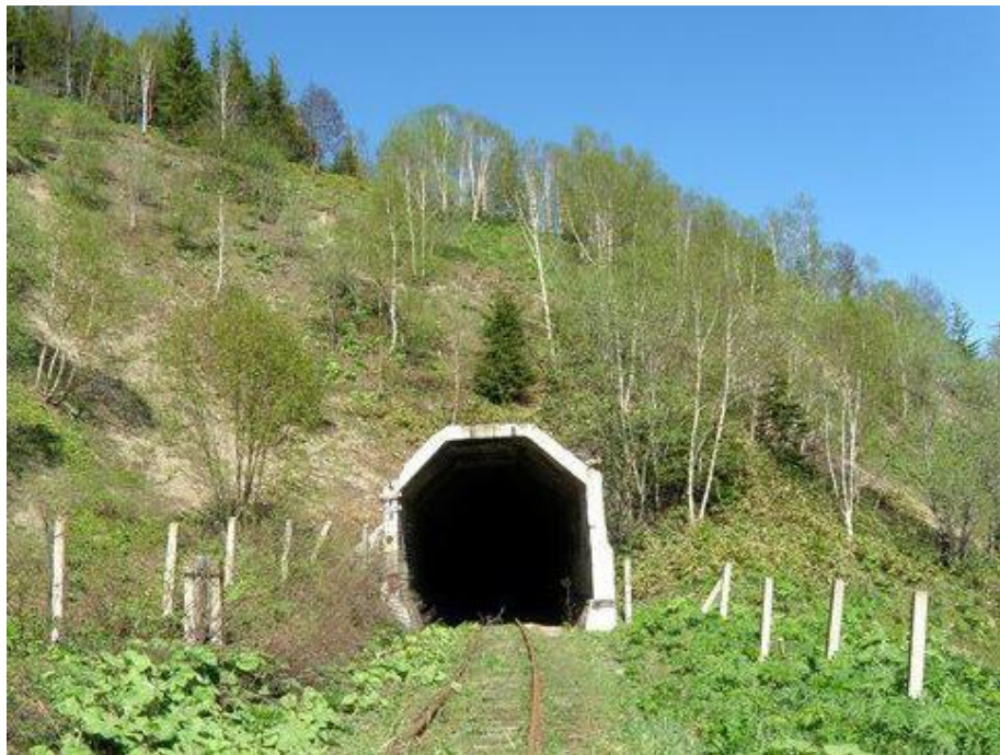
Рис. 3. Въезд в недостроенный тоннель со стороны Мыса Лазарева
