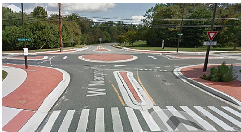
Рис. 8. Миникольцевой перекрёсток с направляющими островками безопасности.
