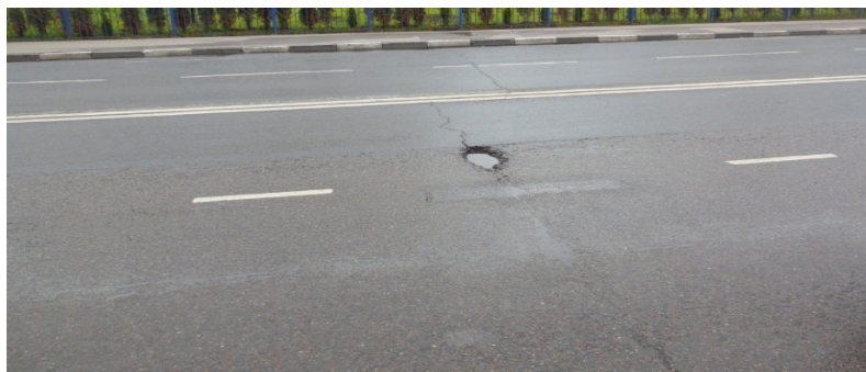
Рис. 2. Разрушение асфальтобетонного покрытия в результате формирования сетей усталостных трещин на проезжей части дороги
