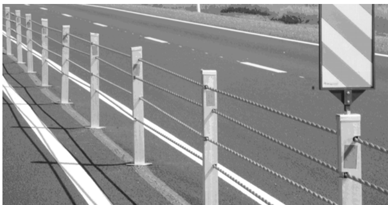
Тросовые дорожные ограждения безопасности
