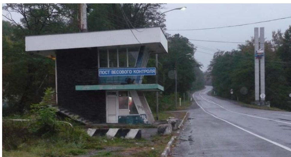
Рис. 3. Здание СПВК на федеральной автомобильной дороге А-161 «Владикавказ – Нижний Ларс – граница с Республикой Грузия»
