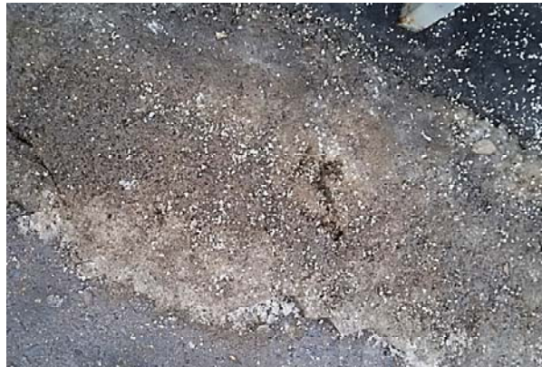
Рис. 5. Некачественное воздействие реагента на снежно-ледяное образование
