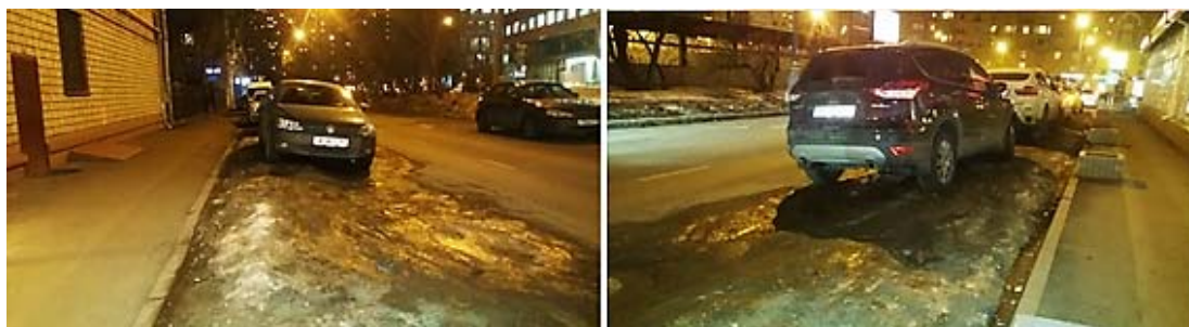
Рис. 2. Снежно-ледяные отложения на автомобильной дороге
