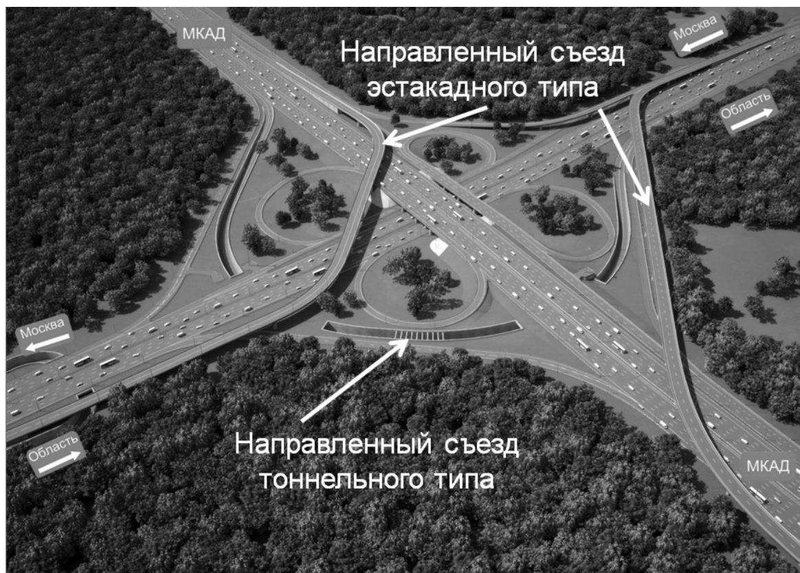
Рис. 3. Транспортная развязка с направленными съездами на пересечении МКАД и Ленинского проспекта
