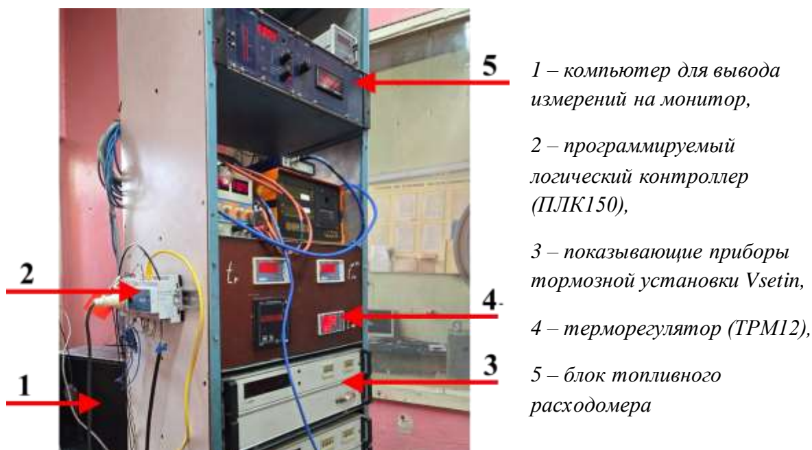
Рис. 2. Монтаж приборов в пультовом отсеке бокса
