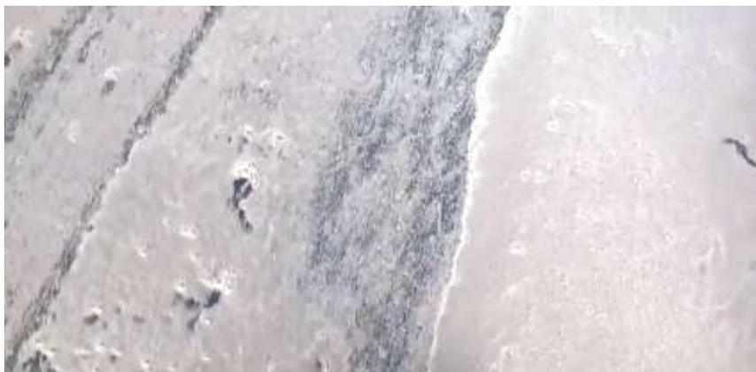
*Рис. 2. Поверхность взлётно-посадочной полосы после прохода щёточного очистителя*
