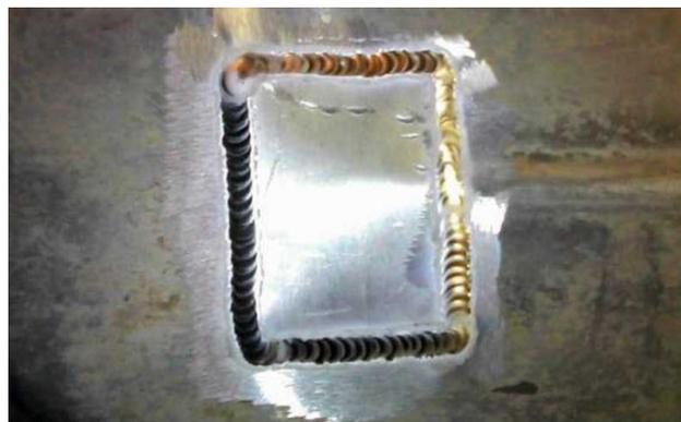
*Рис. 10. Приварка заплаты на внешней стороне рубашки охлаждения блока цилиндров*
