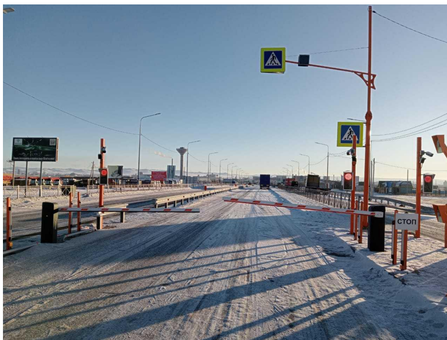
Рис. 2. Автомобильный пункт пропуска Забайкальск, оснащенный ПМУ
