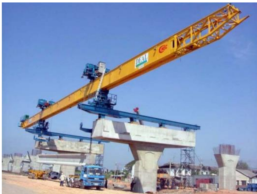
Рис. 3. Портальный кран с одной облегченной главной балкой
