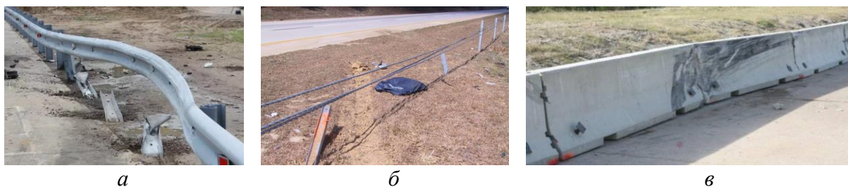
Рис. 3. Вид ограждения после столкновения с легковым ТС: а – барьерное; б – тросовое; в – парапетное
