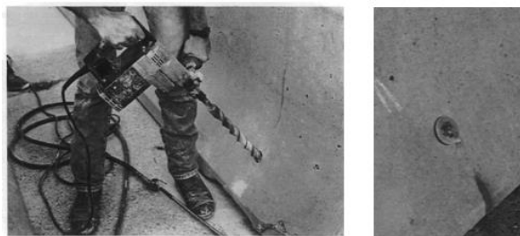
Рис. 4. Усиление парапетного ограждения при помощи анкера
